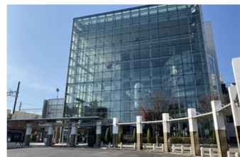
松江テルサ (松江勤労者総合福祉センター) 〒690-0003島根県松江市朝日町478-18 (JR松江駅前)
